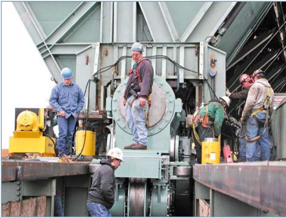
Afbeelding 4 Een nieuw onderstel op zijn plaats. Een wiel en twee geleidingsrollen zijn zichtbaar. Ingenieur Jim Ronning staat links, Dale Andersom van Price Erecting staat op het onderstel, midden.
