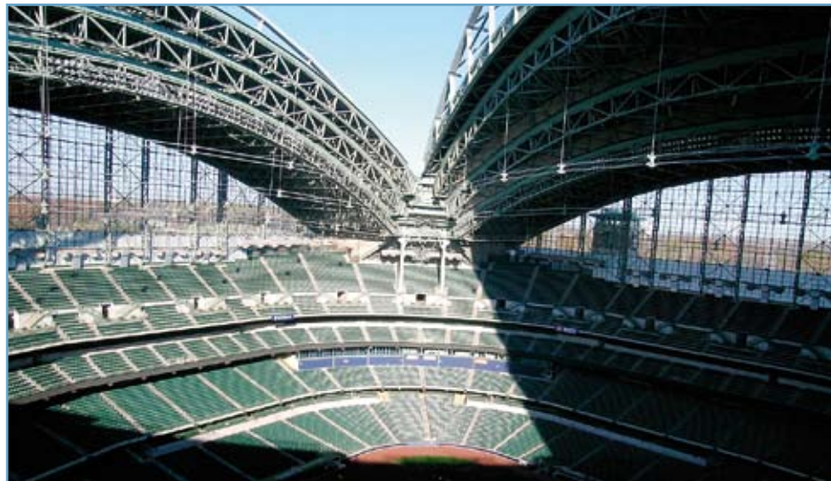
Afbeelding 1 Het dak ingetrokken; rechts zijn drie dakpanelen 'opgestapeld', links twee.
